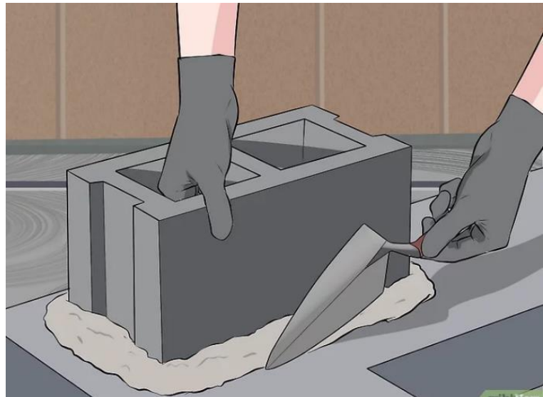
Figura 6 – Assentamento do primeiro bloco de concreto Fonte: COBRAPE (2024).
