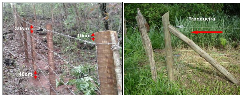
Figura 20 – Fotos Ilustrativas do modelo adotado para cercamento das nascentes Fonte: Localmaq (2017) - Município de Lassance, adaptado por SAMENCO (2020)
