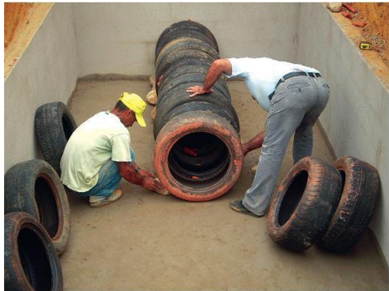
Figura 10 – Instalação da câmara receptora com pneus irreversíveis
