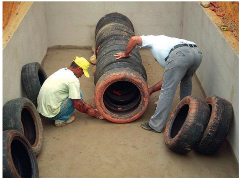
Figura 10 – Instalação da câmara receptora com pneus irreversíveis
