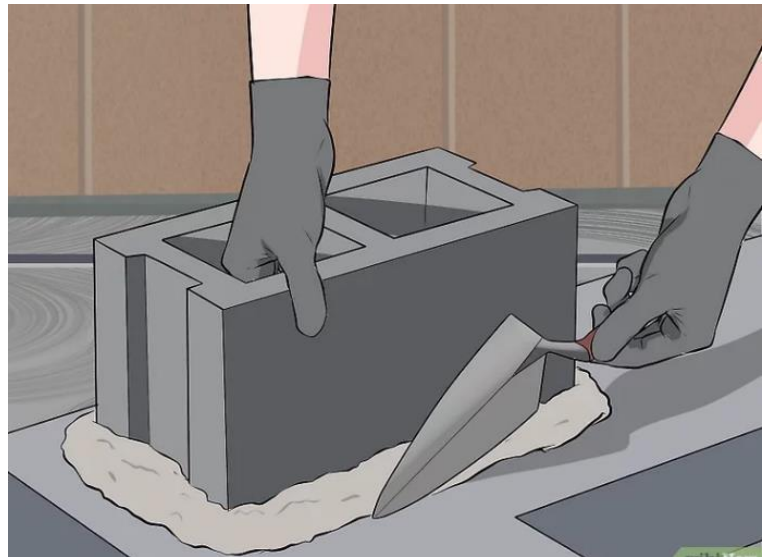
Figura 6 – Assentamento do primeiro bloco de concreto
