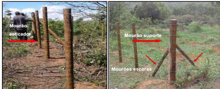
Figura 21 – Fotos Ilustrativas do modelo adotado para cercamento das nascentes
